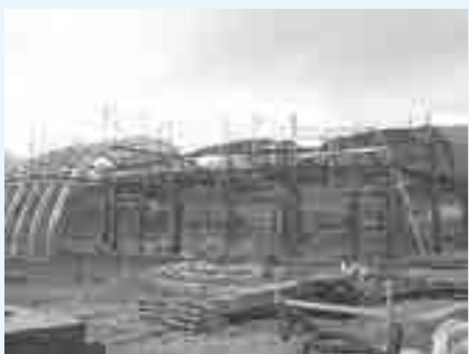
建設がすすむ健康福祉施設
