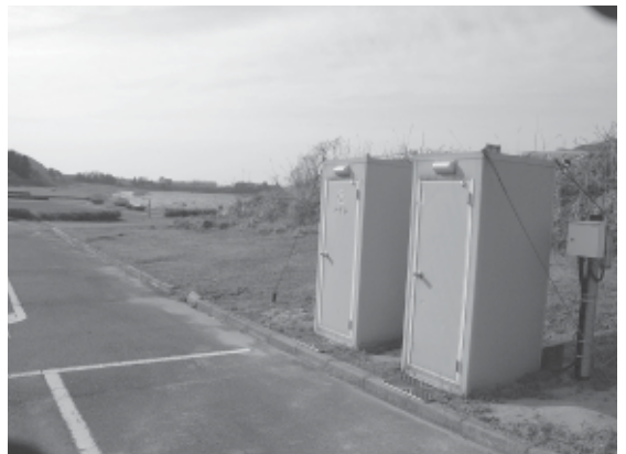
谷口河川公園 簡易トイレ
