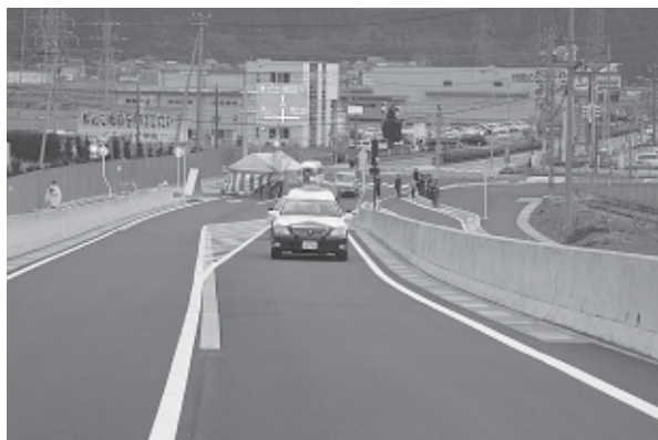
県道松岡舟橋観音町跨線橋
