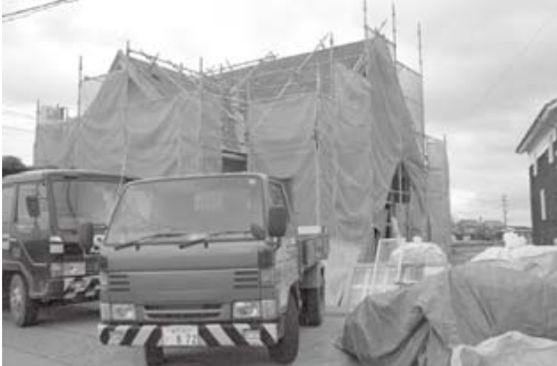
リフォーム工事
