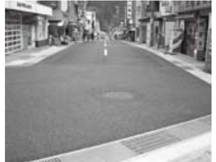
門前カラー舗装工事
