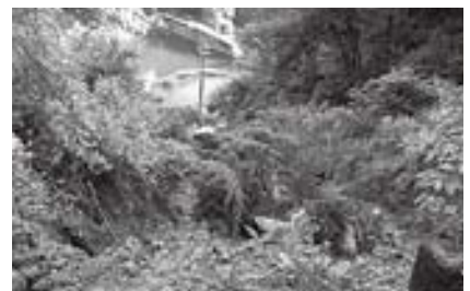
7月7日上浄法寺地区土砂崩れ
