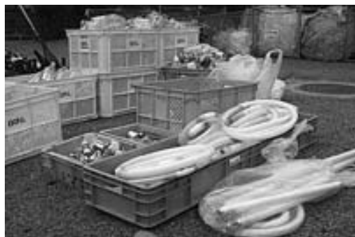
不燃物回収状況
