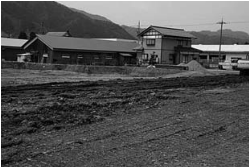
工事中の永平寺温泉（4月中旬撮影）
