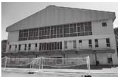
松中学校体育館
