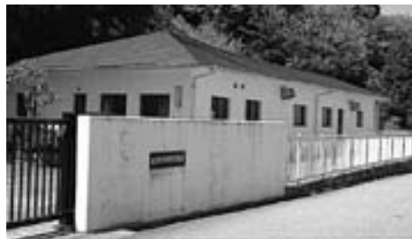
吉野農業集落排水処理場
