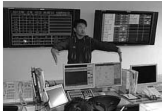
大野市消防本部通信指令室
