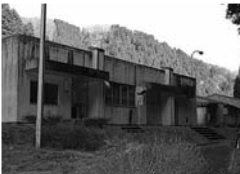
昭和55年に供用開始の志比浄化センター
