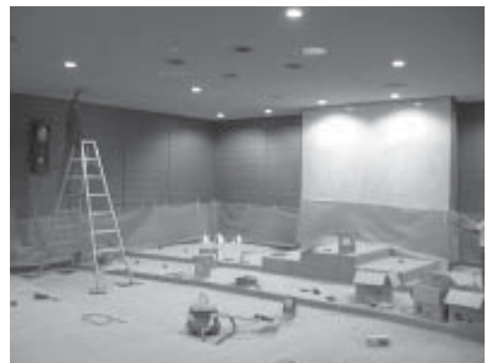
改修中の議場
