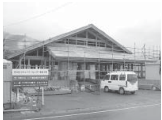
建設中の谷口区コミュニティセンター
