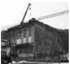
解体される松岡織物会館
